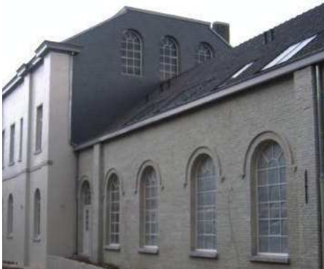
Figure 221: Ancienne Maison communale de Laeken
