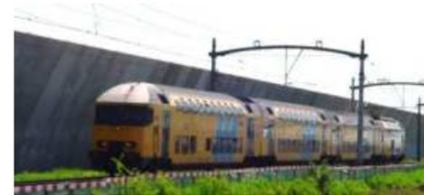
Figure 113 : Mur antibruit simple opaque
