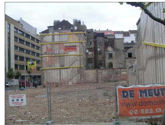
Boulevard Baudouin - Rue du Frontispice Boudewijnlaan - Frontispiesstraat
