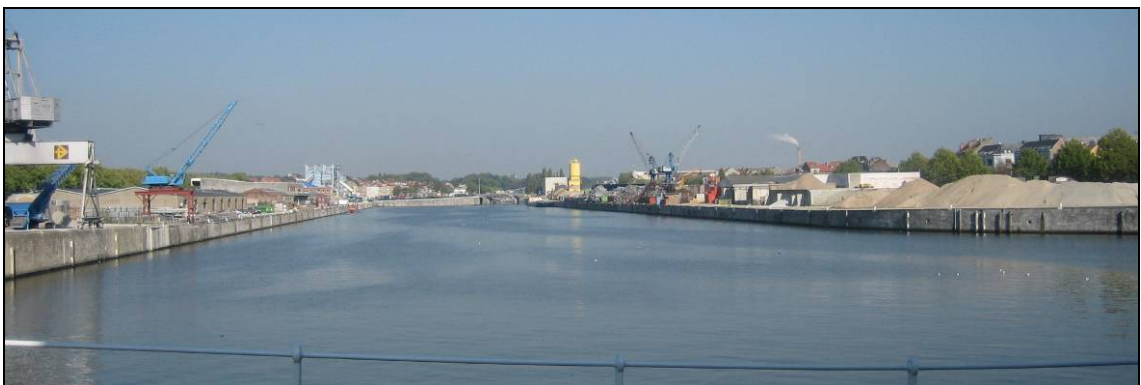
Figure 16 : Vue depuis le pont métallique des Armateurs vers le bassin Vergote
