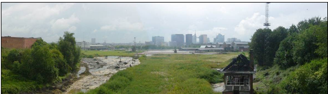
Figure 24 : Vue depuis le pont du boulevard du Jubilé
