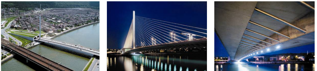
Figure 13 : Pont liaison E40-E25 (arch. Greisch)
