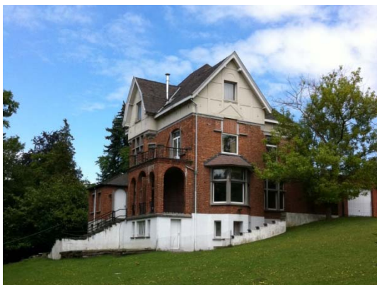
Maison significative à côté du parking devant l'hôpital
