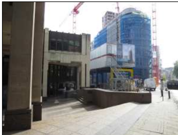
Figure 6: Galerie le long de la rue Belliard
