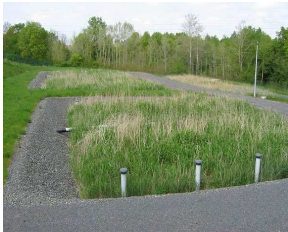
Système d'épuration par marais filtrants artificiels
