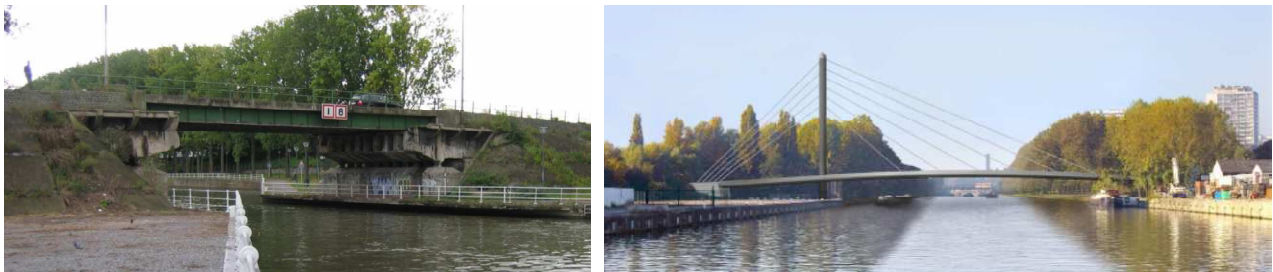
Le pont aujourd'hui et le nouveau Pont Marchant : disparition du rétrécissement entre le bassin de Biestebroeck et le bassin de Batelage
